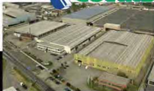
COVIND S.p.A. Strada della Cebrosa, 68/70/72 Settimo T.se (TO)
